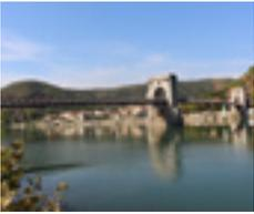
Avec ses câbles de fer et sa pile centrale, le pont d'Andance est le plus vieux pont suspendu de France encore utilisé aujourd'hui. Il fut construit en 1827 par Marc Seguin, le génial inventeur d'Annonay.
